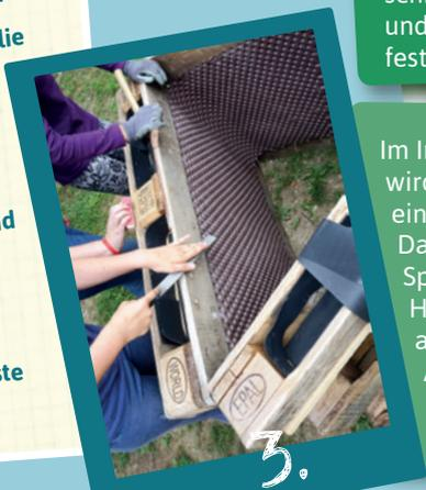
Im Innenraum des Dreiecks wird Noppenfolie mit einem Tacker befestigt. Damit sich niemand Splitter holt, muss das Hochbeet kräftig abgeschliffen werden. Anschließend kannst du es mit einer Lasur anmalen.
